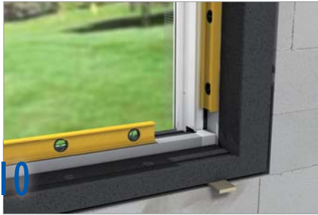
10 Allineare definitivamente in verticale ed in orizzontale l'elemento tramite i profili in PVC e le viti di regolazione è consigliabile l'utilizzo di una livella laser. Attenzione: L'allineamento dell'elemento determina contemporaneamente l'allineamento della finestra e la sede della stessa..
