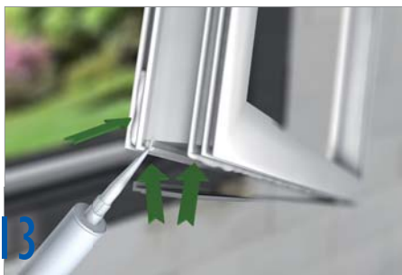
13 Montare il profilo ad L in dotazione sul traverso basso della finestra, utilizzando il collante MS 460. Sigillare le scanalature esterne (angoli) per 10 cm in ciascun lato.
