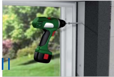
11 Avvitare l'elemento nelle mazzette della muratura, utilizzando viti adeguate al tipo di muratura esistente (es.: viti AMO-turboviti). In questa sede è necessario assicurarsi che le spalle siano perpendicolari.
