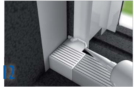
12 Sigillare, senza giunture, gli angoli dei particolari superiore ed inferiore con collante MS 460.
