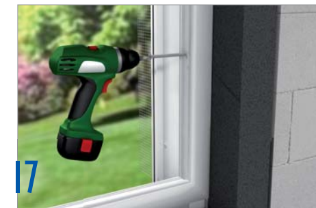
17 Avvitare la finestra alla muratura fissa con le viti per murature (come sopra), facendole passare attraverso l'elemento ROKA-CO 2 MPACT.
