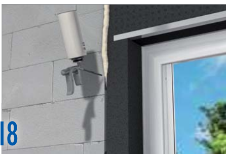
18 Schiumare l'intercapedine tra CO 2 MPACT e muratura con schiuma PU, su tutto il perimetro effettuando tre passaggi: interno al centro ed esterno.
