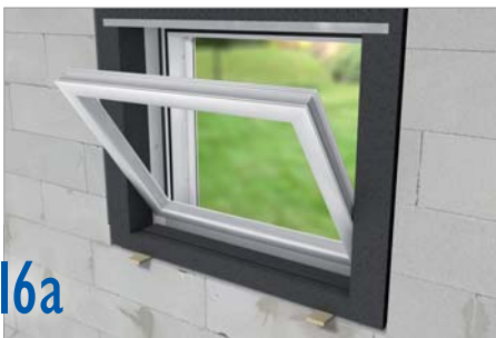
16a Montare la finestra dritta ed allinearla al centro (orizzontalmente).
