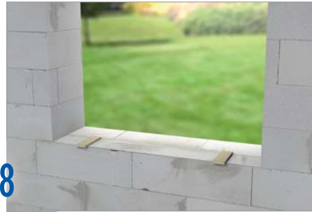
8 Appoggiare i profili in PVC sulla muratura per il preallineamento.
